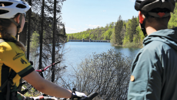
Blick auf die Neustädter Trinkwassertalsperre
